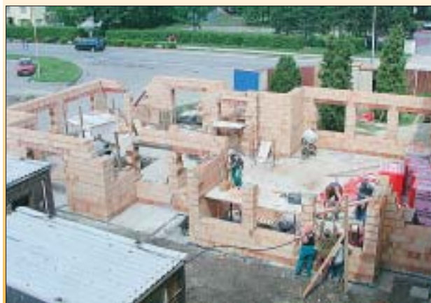
Práce na výstavbě vstupního areálu BORS Břeclav a.s.
