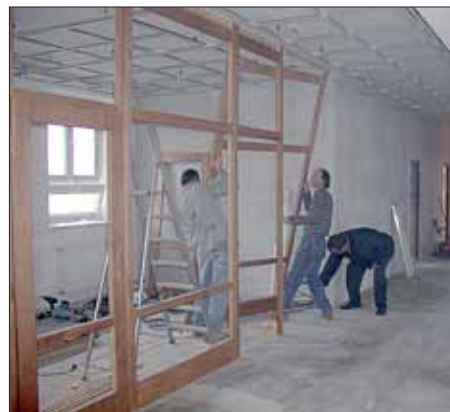
Práce na úpravách nového pracoviště divize nákladní dopravy
