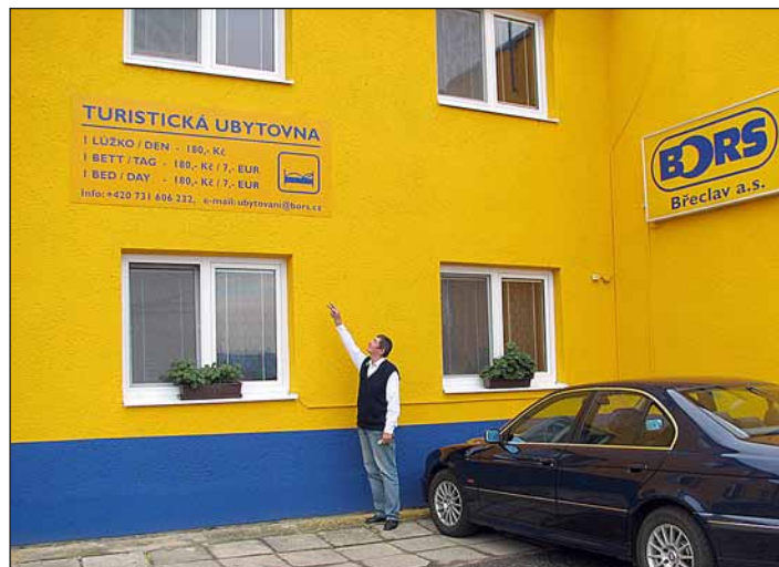
Nová fasáda ubytovny v Mikulově
