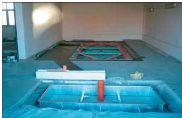
Od února probíhají stavební úpravy ve vytyčených prostorách servisu Renault.
