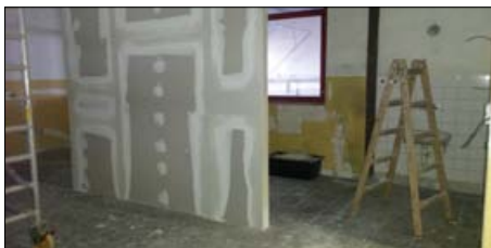
Dílna během rekonstrukce
